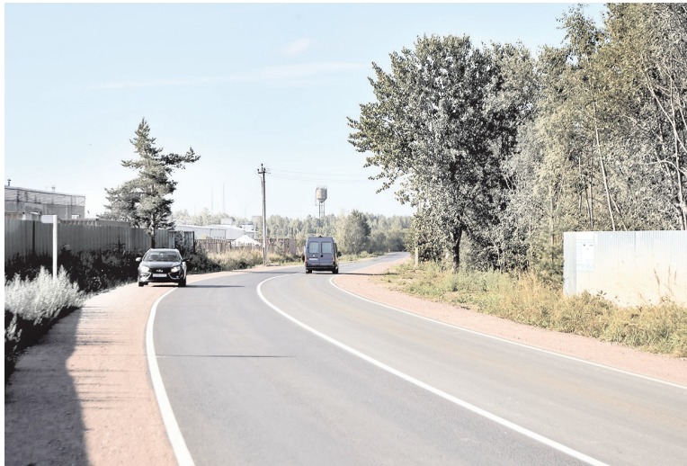
Ленобласть и Петербург сообща ремонтируют подъезды к садоводствам
