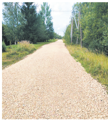
Ремонт дороги в деревне Новое Поддубье, Гатчинский район
