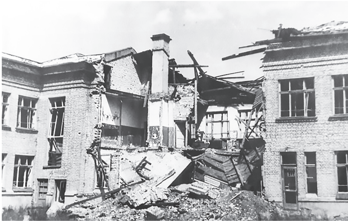
Фотография разрушенной школы
